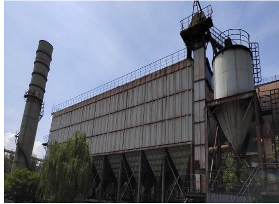
2#高炉-矿槽烟气-布袋除尘器
