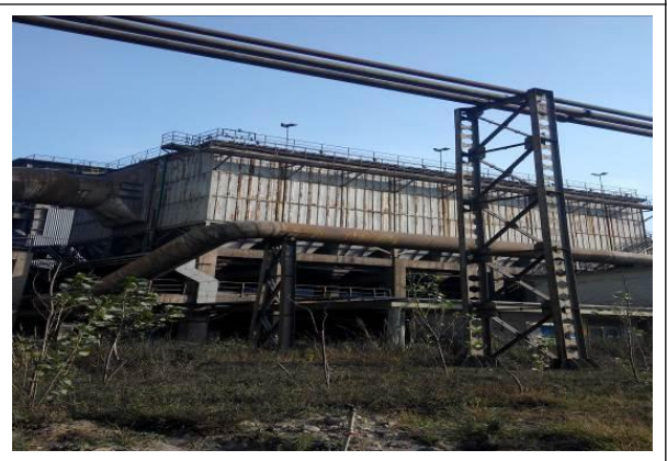
烧结机-燃料烟气-布袋除尘器
