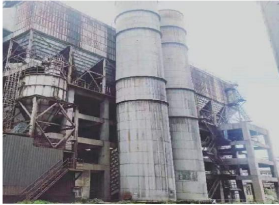
2#高炉-出铁场烟气-布袋除尘器
